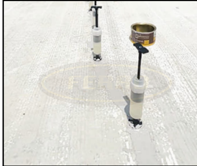
ฉีดซ่อมรอยร้าวด้วยชุดอีพ็อกซี่ ฉีดซ่อมรอยแตกร้าวคอนกรีต (เฟอร์โรเรซ 717/คิท)
