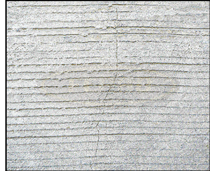
หลังเททับด้วย เฟอร์โรกริต 216 ทำให้รอยร้าวมีขนาด เล็กลง
